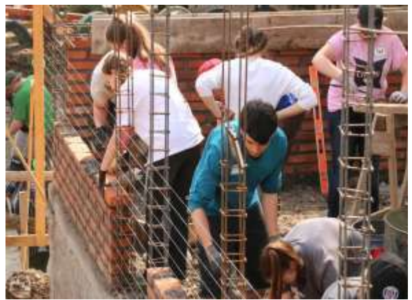
Constructing walls at 15 de Septiembre
