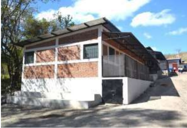
New classrooms at 15 de Septiembre
