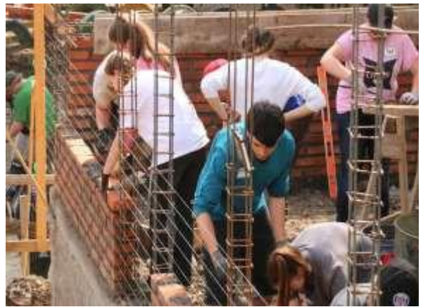
Constructing walls at 15 de Septiembre
