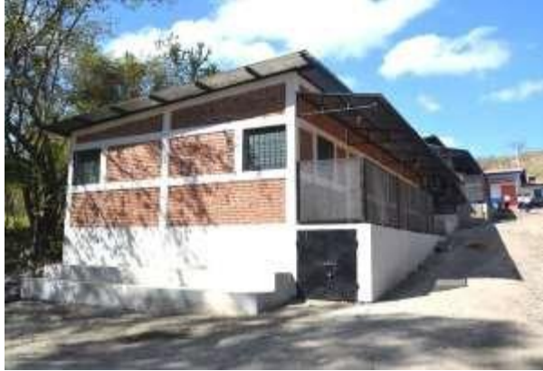
New classrooms at 15 de Septiembre
